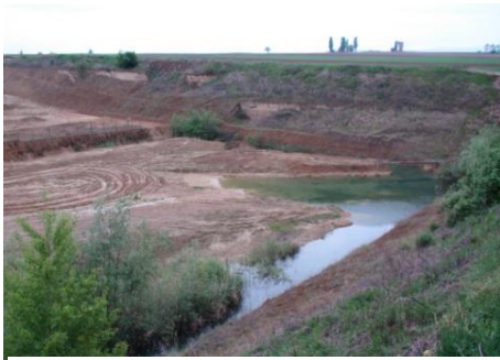
Photographie 5: bassin et fossés attenants.
