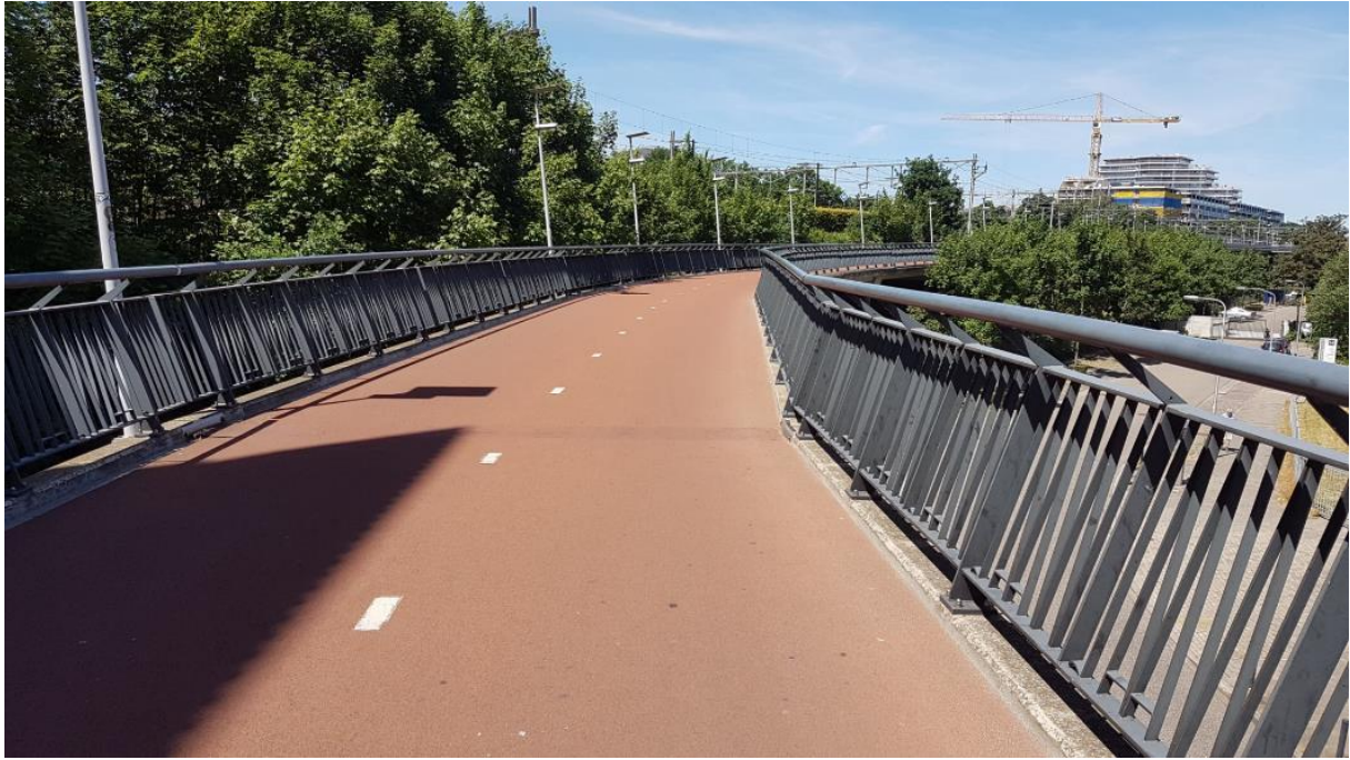
Figure 1 Nîmègue, Pays bas: le garde-corps épouse la silhouette du cycliste et augmente ainsi la largeur roulable de la piste cyclable
