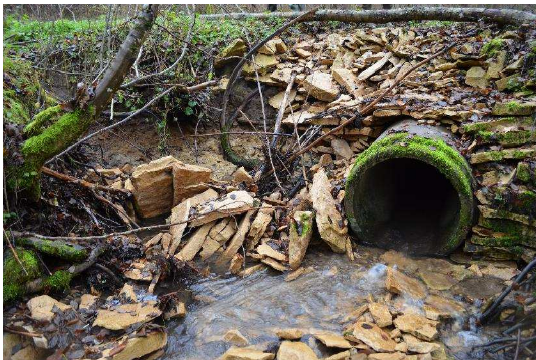
Photo 3 : aval du passage busé
