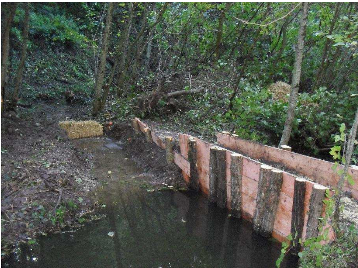
Photo 2 : Barrage et botte de paille filtrante mis en place lors de la phase test en 2011
