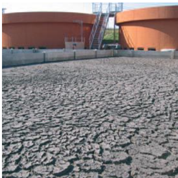
Séchage des boues d'une station à lit bactérien
