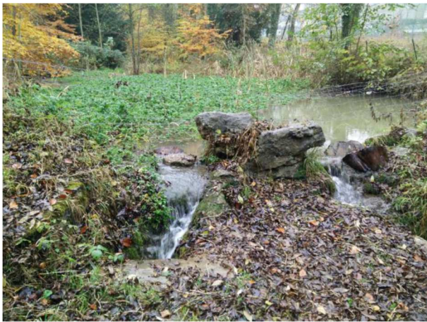
Plan d'eau amont et barrage enroché
