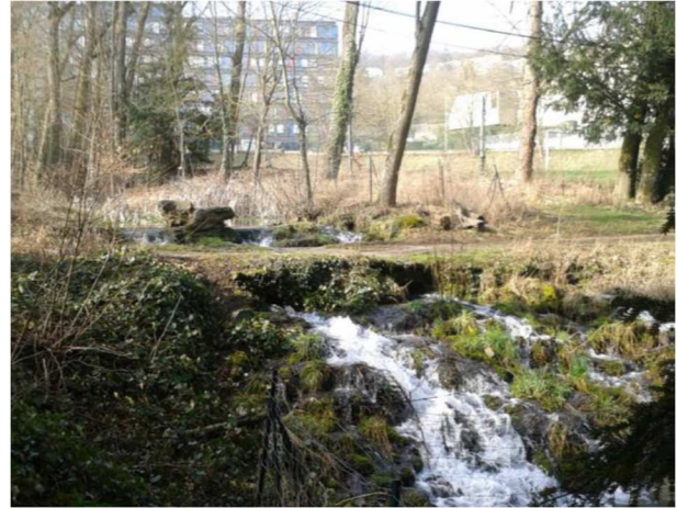
Ouvrage vu de l'aval et cascade
