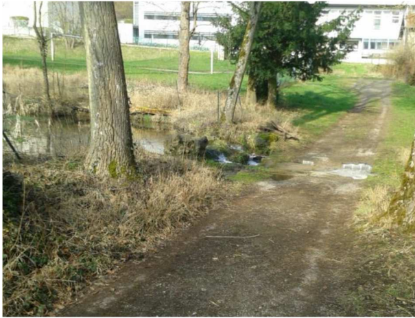
Ouvrage de franchissement
