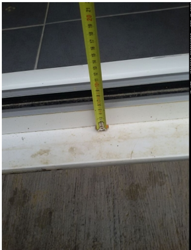
Ressaut >2cm côté extérieur entre terrasse et logement
