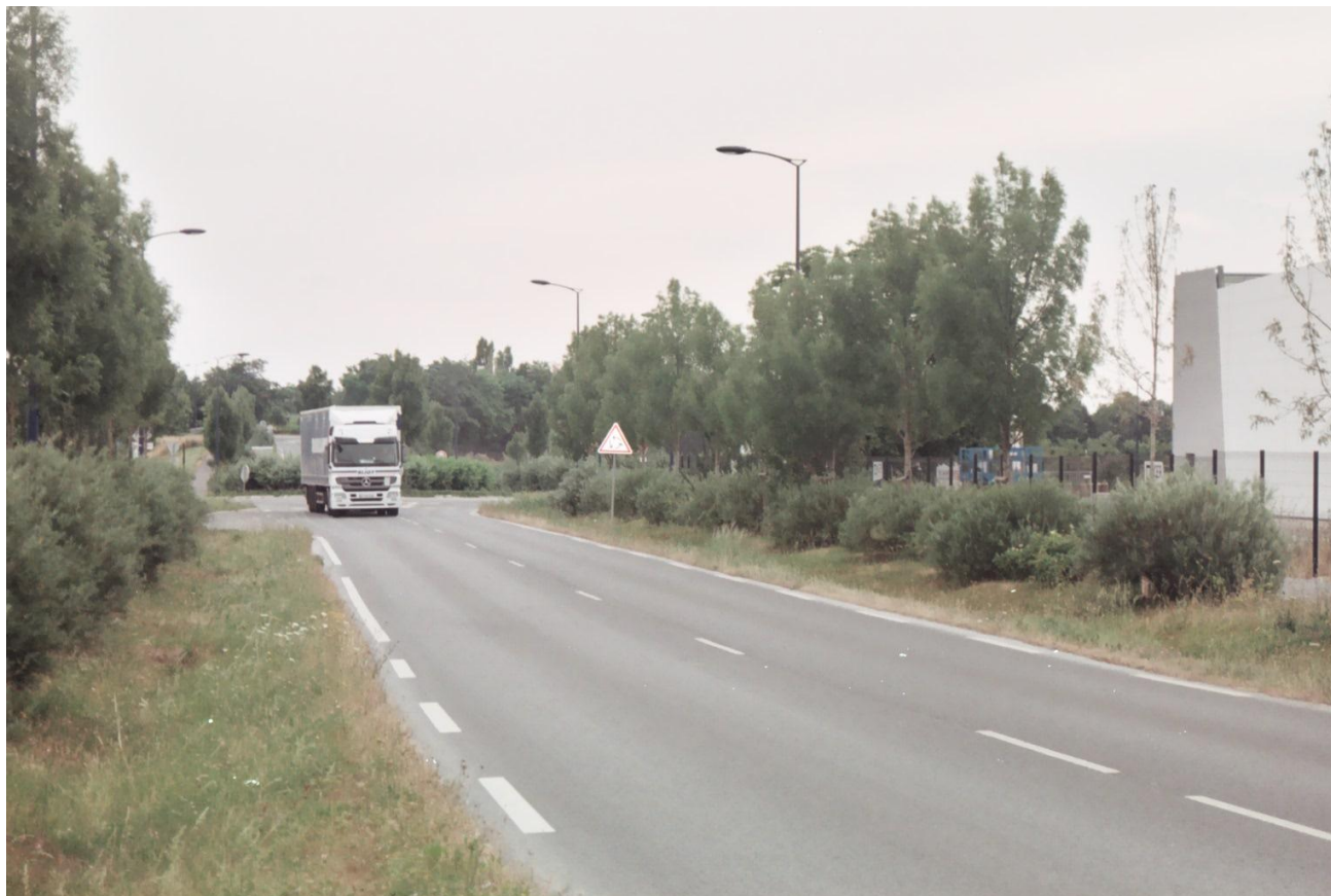
2- Carrefour giratoire permettant l'accès au site (à gauche – Ouest) vu dans l'axe de l'avenue du Berceau de l'Aviation, à droite la zone d'activités en cours d'urbanisation
