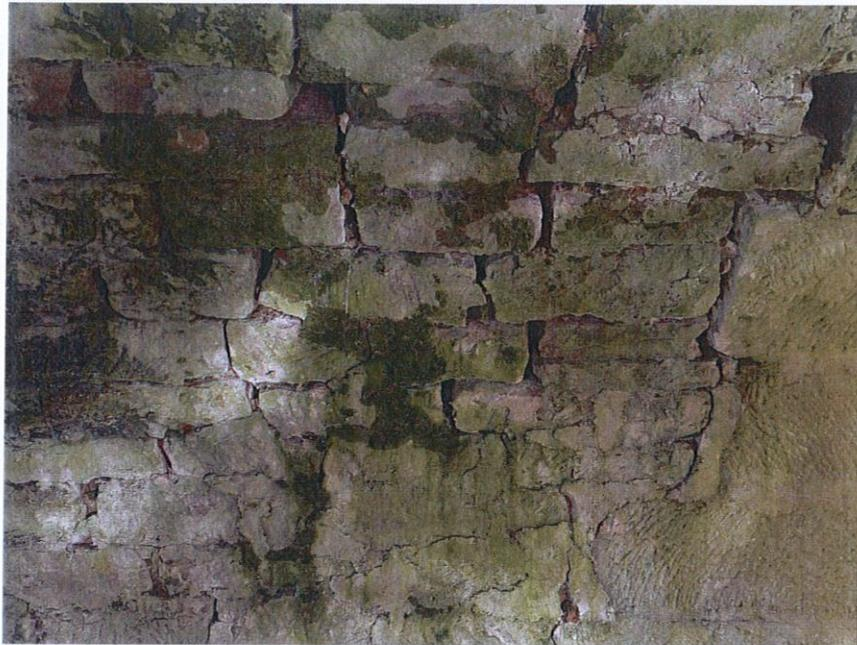
Photo 3 : Disjointoiement généralisé sur la douelle avec traces d'humidité
