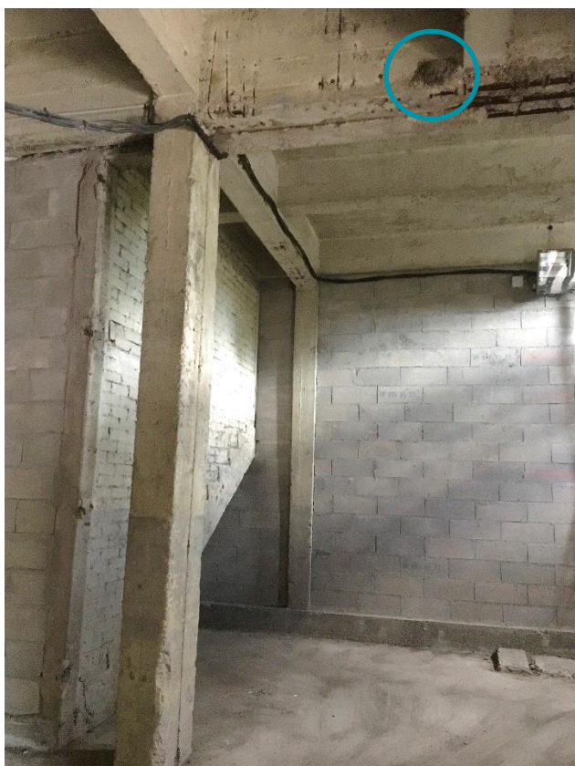
Figure 4 : Un des 3 nids du rez-de-chaussée du bâtiments 2-1941-1941 (juin 2019)
