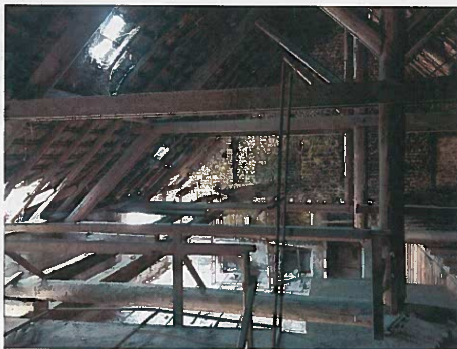
Combles du bâtiment principal
