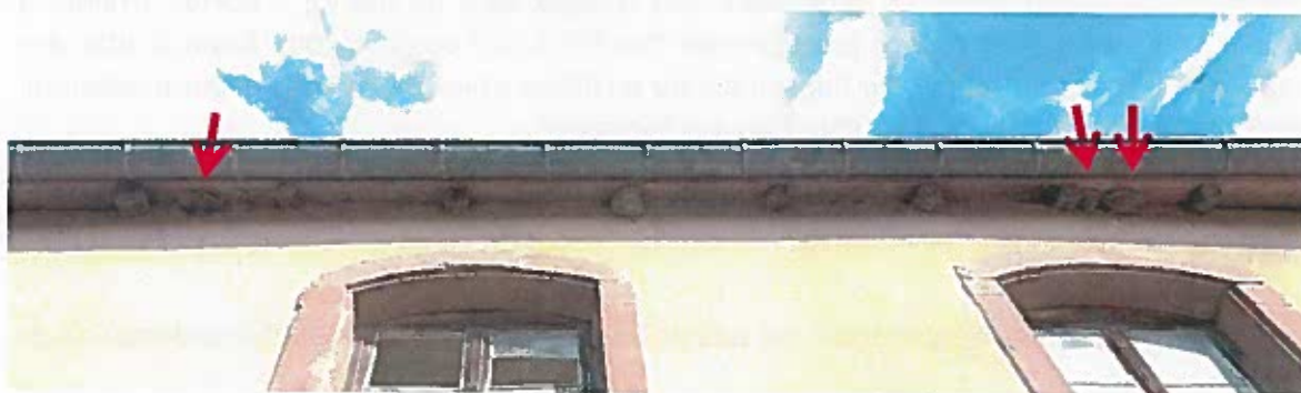
Trois nids d'Hirondelle de fenêtre sur la façade sud du bâtiment
