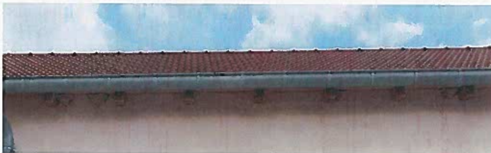
Nids d'Hirondelle de fenêtre sur la façade ouest du restaurant « M »
