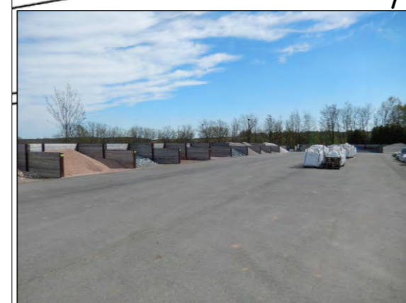
Aire de négoce de matériaux
