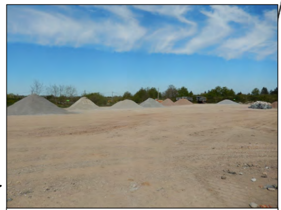
Aire de transit des matériaux (granulats naturels et recyclés) et plate-forme de recyclage
