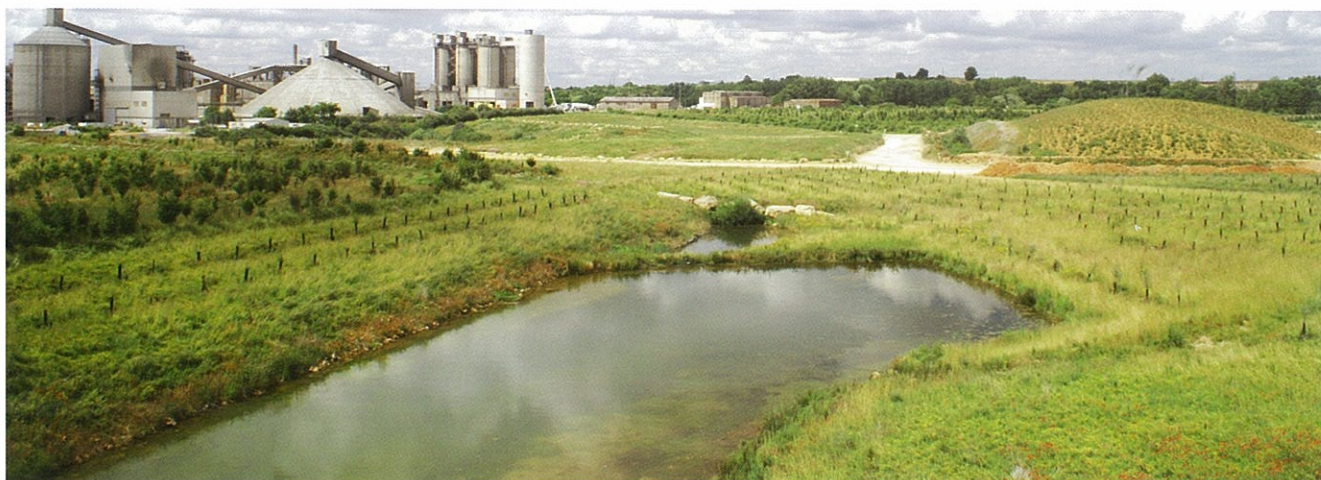
Ce bassin paysager mis en place dans le cadre de la remise en état du site aurait pu être valorisé par des aménagements écologiques sur une partie de sa surface, notamment des portions de berges en pente douce.
