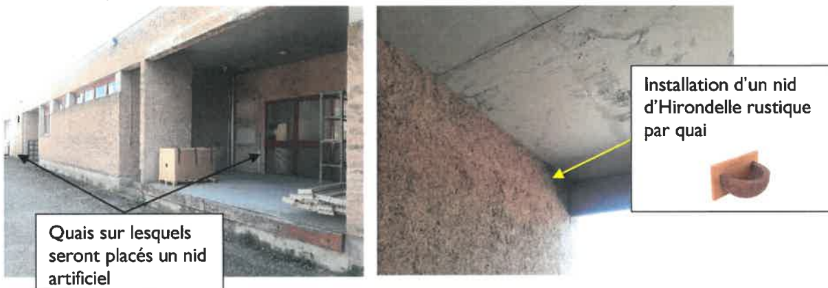
Photo 6 : Installation de nids simples sur deux quais de déchargements
