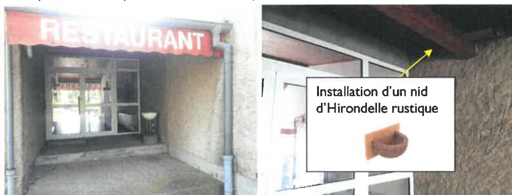
Photo 7 : Installation d'un nid sur l'entrée du restaurant
