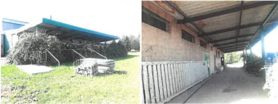
Photo 4 : Préau du bâtiment de sport
