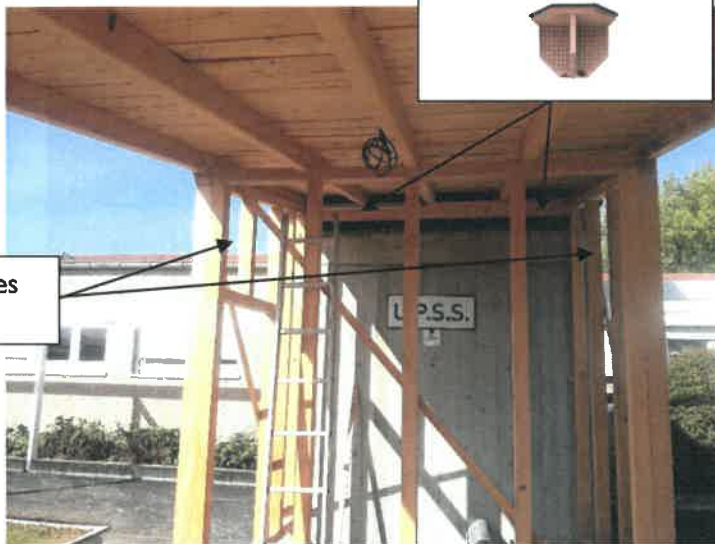
Photo 10 : Installation d'un nid sous le préau de l'UPSS
