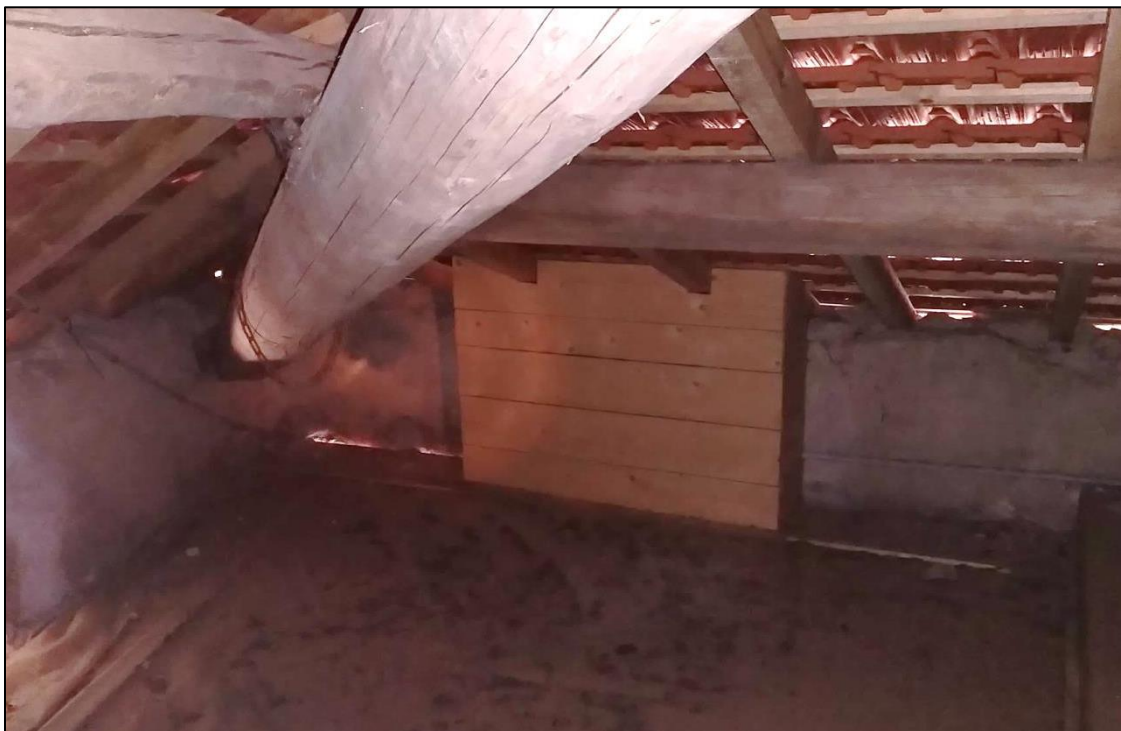
Aménagement pour l'entrée des chiroptères combles de l'aile Est de la ferme.
