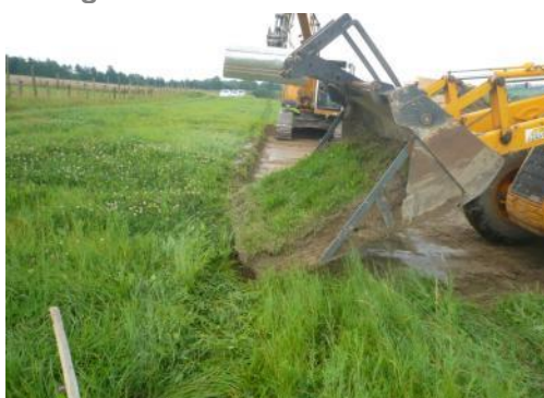
Repose de la plaque sur le site de transfert
