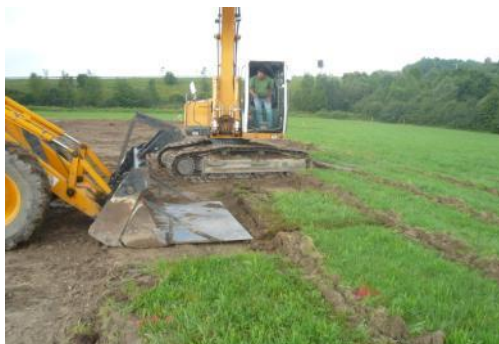
Prélèvement d'une plaque au godet rallongé
