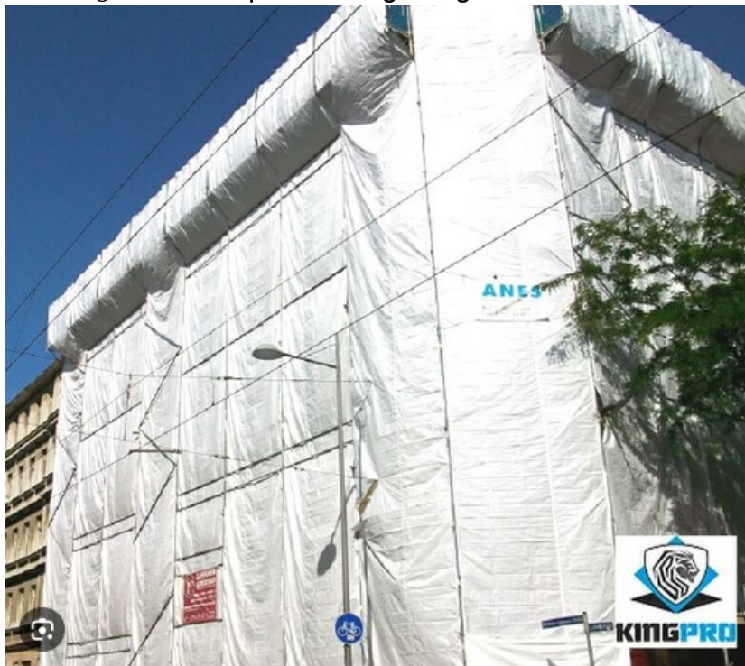
Figure 10. Exemple de bâchage intégral d'un monument.
