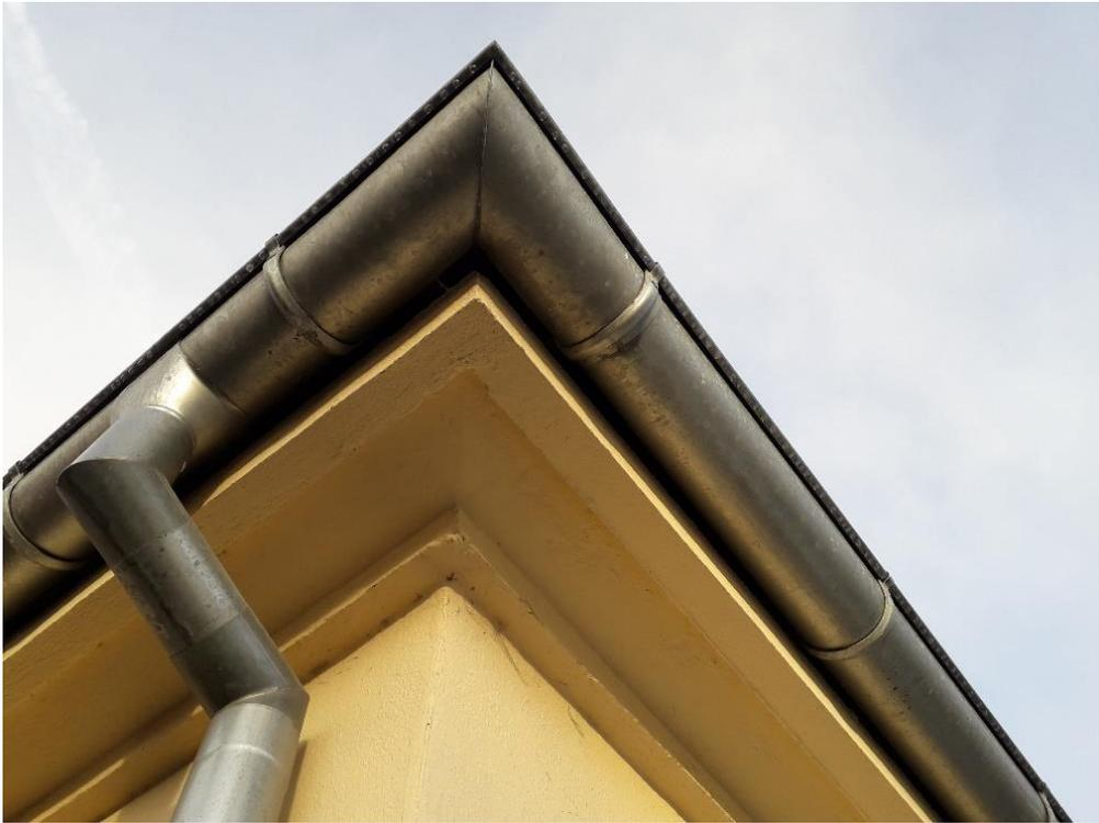
*Voir ci-après photo de détail de la corniche du bâtiment des « Brigades Vertes » avec débord de 31 cm (façade EST, au-dessus des portes de garage).*
