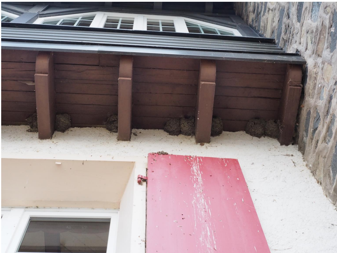
Nids d'hirondelles – Poutres 13 à mur gauche
