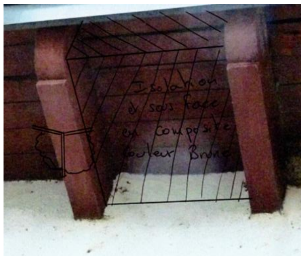
Travaux d’isolation envisagés (isolation de 12 cm et sous-face en composite de couleur brune)
