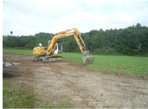
Découpe finale au tranchant du godet de la pelle
