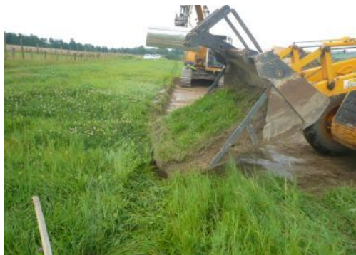
Repose de la plaque sur le site de transfert
