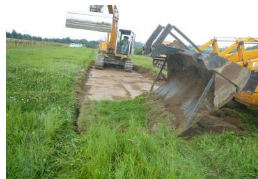
Dépose avant ajustement des plaques avec le godet de la pelle
