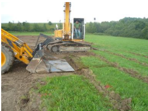
Prélèvement d'une plaque au godet rallongé
