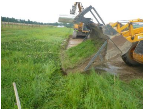
Repose de la plaque sur le site de transfert
