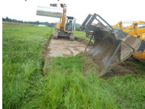
Dépose avant ajustement des plaques avec le godet de la pelle
