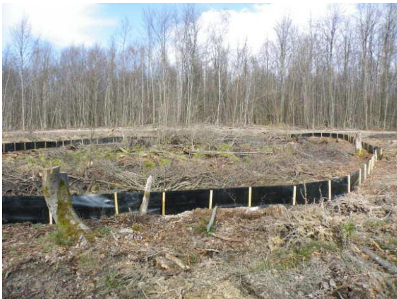
Exemple de mise en place de barrières anti-herpétofaune (source : ECOLOR)
