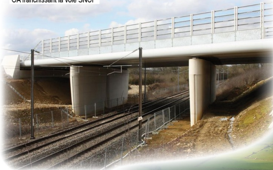
OA franchissant la voie SNCF
