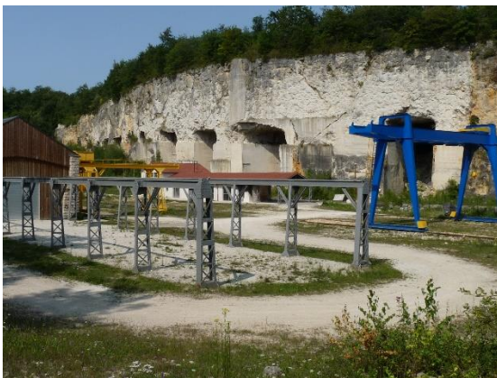
Parties souterraines de la carrière d'Euville
