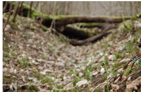
Fossé de drainage
