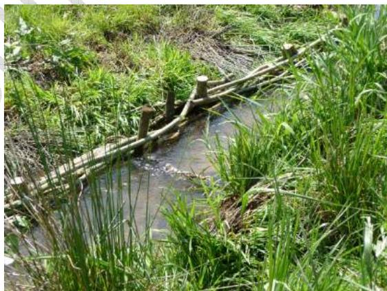
Stabilisation des berges par tressage réalisé sur le ruisseau de l'Heymonrupt (Aappma Esch)
