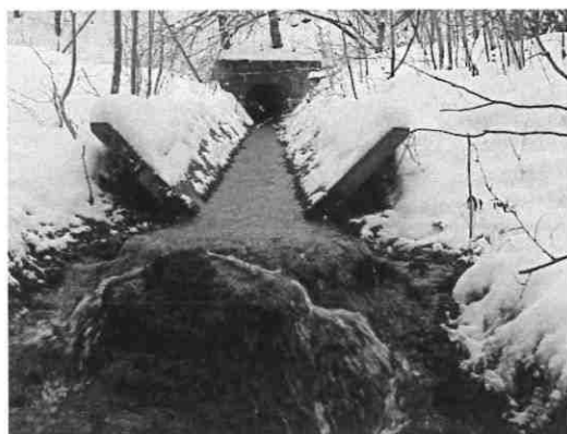
Busage sous autoroute, combe Royer
