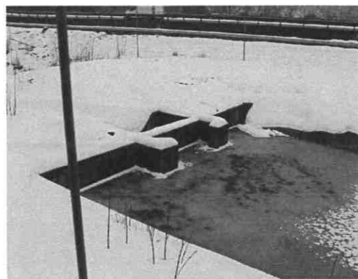
Bassin de décantation, en amont combe Royer
