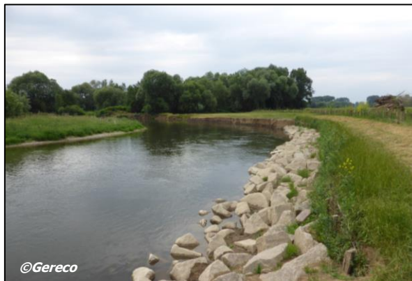
Secteur de l'Ill en cours de renaturation. En rive gauche, on distingue les bancs de graviers végétalisés. En rive droite, au fond, une berge vive nouvellement érodée
