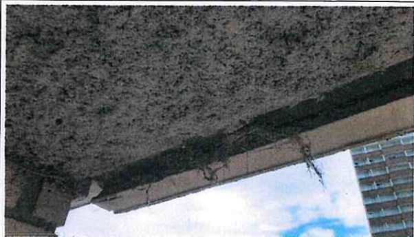
Nid de Moineau domestique dans la structure du bâtiment
