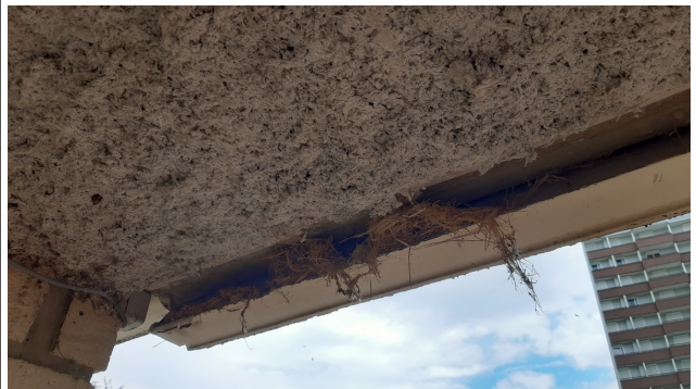
Nid de Moineau domestique dans la structure du bâtiment
