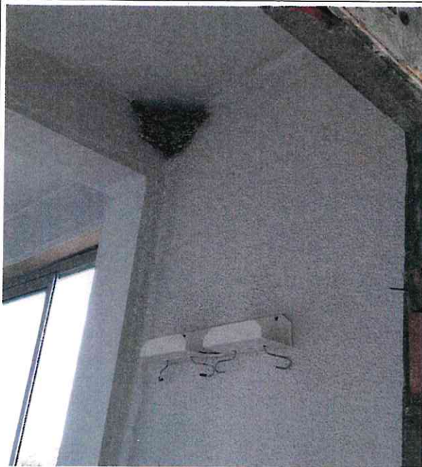
Nid construit à l'intérieur du bâtiment après enlèvement des fenêtres
