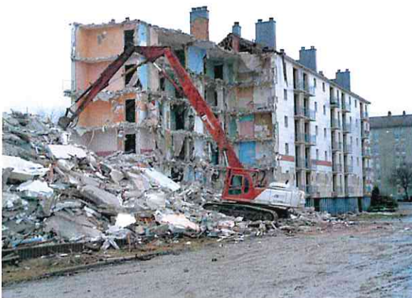
(Photo d'archives indiquant une démolition par grignotage)
