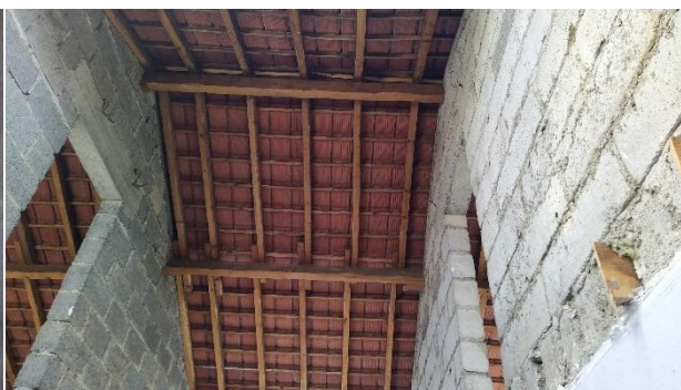
Illustration 3 : combles immeuble Réunion
