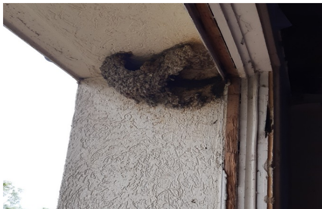
Nid dont la partie contre la fenêtre est détruite et reconsolidée fraîchement
