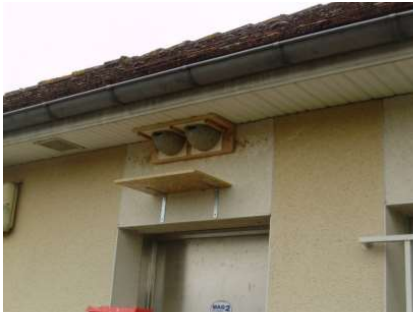
Six nids artificiels non occupés sur le bâtiment de l'ouvrage de partage (posés en 2015)
