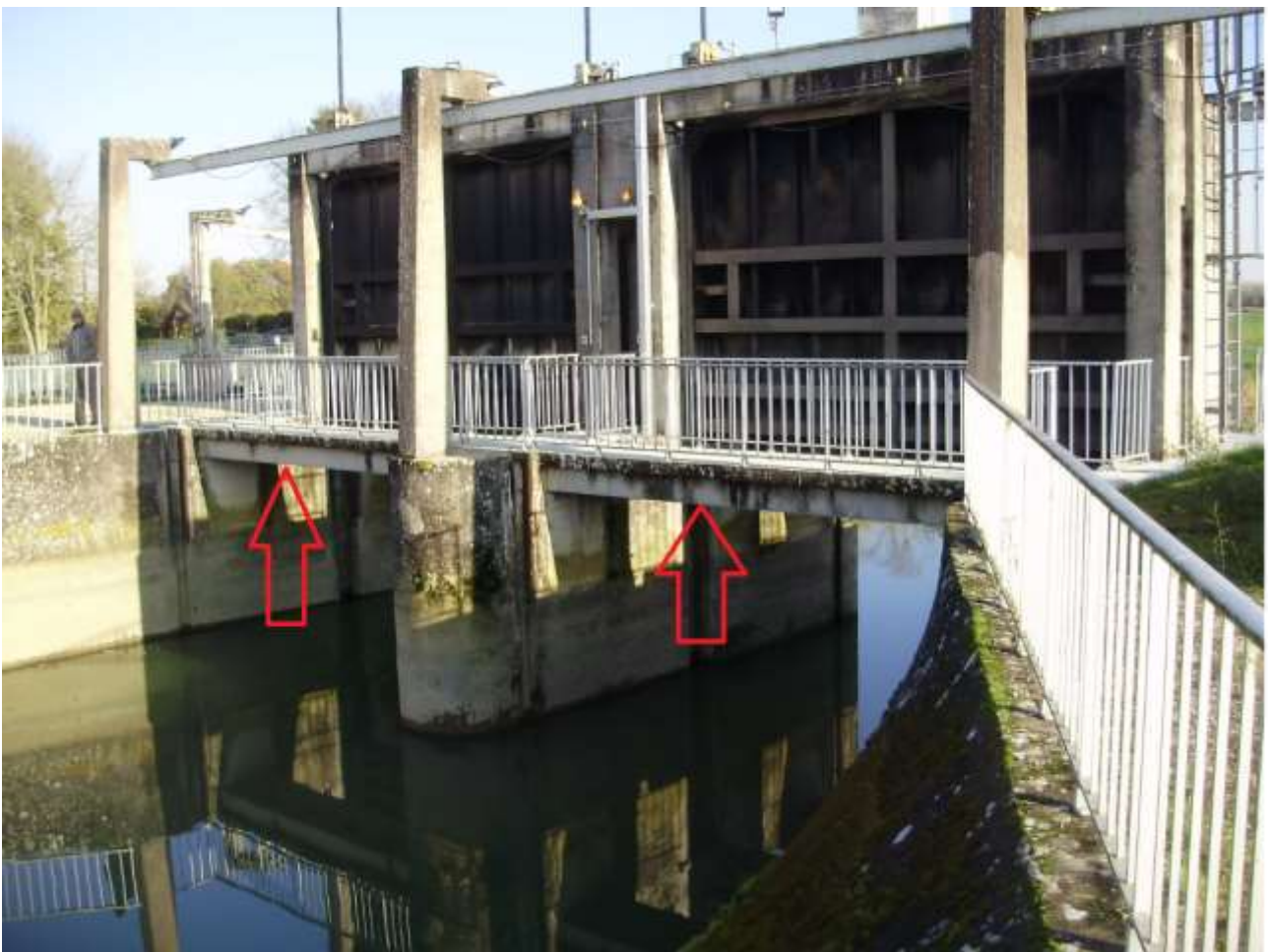
Photos des nids sous les passerelles
