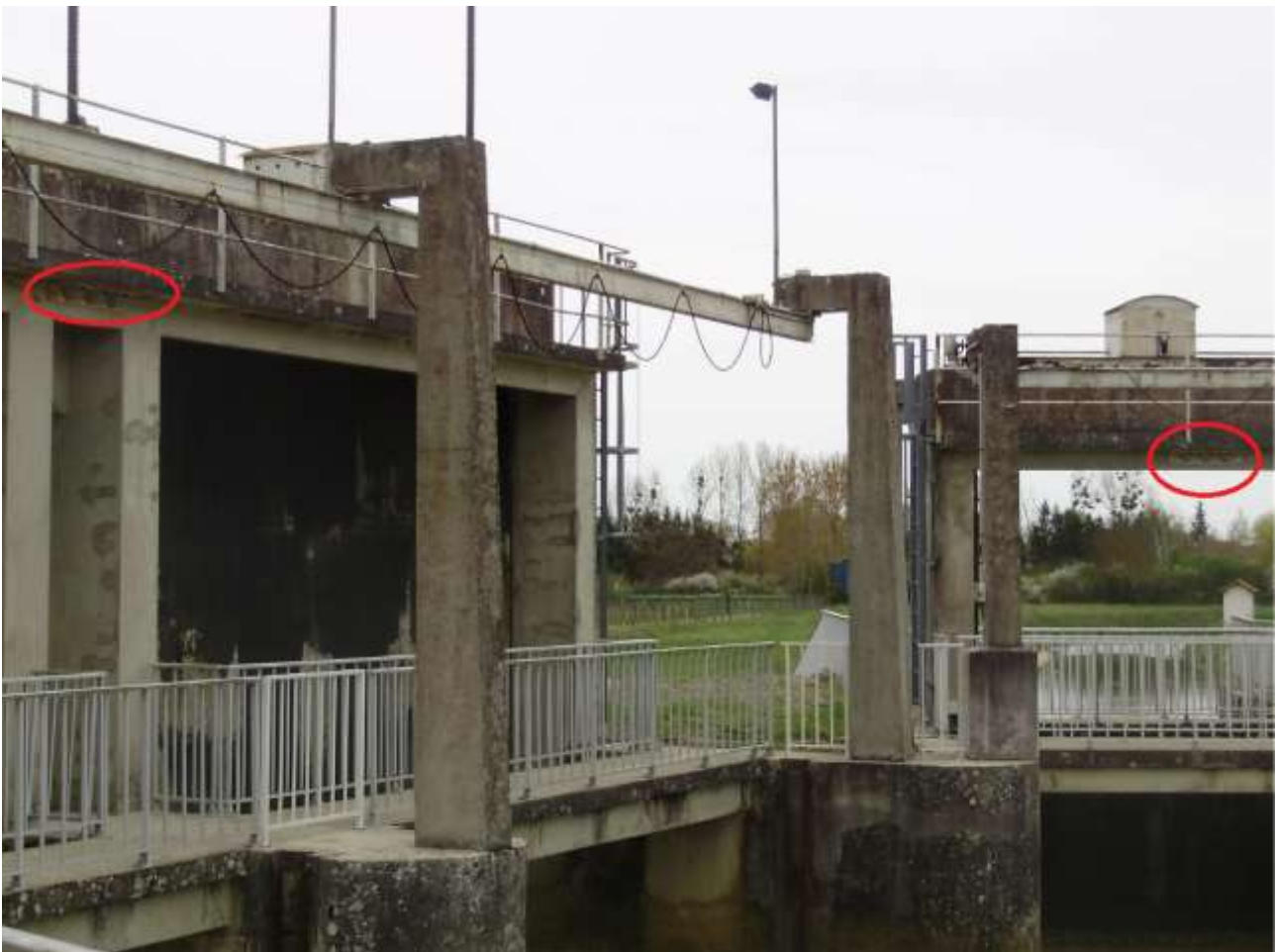
Présence de 60 nids sous les trois passerelles de l'ouvrage Sous les deux passerelles de l'amont
