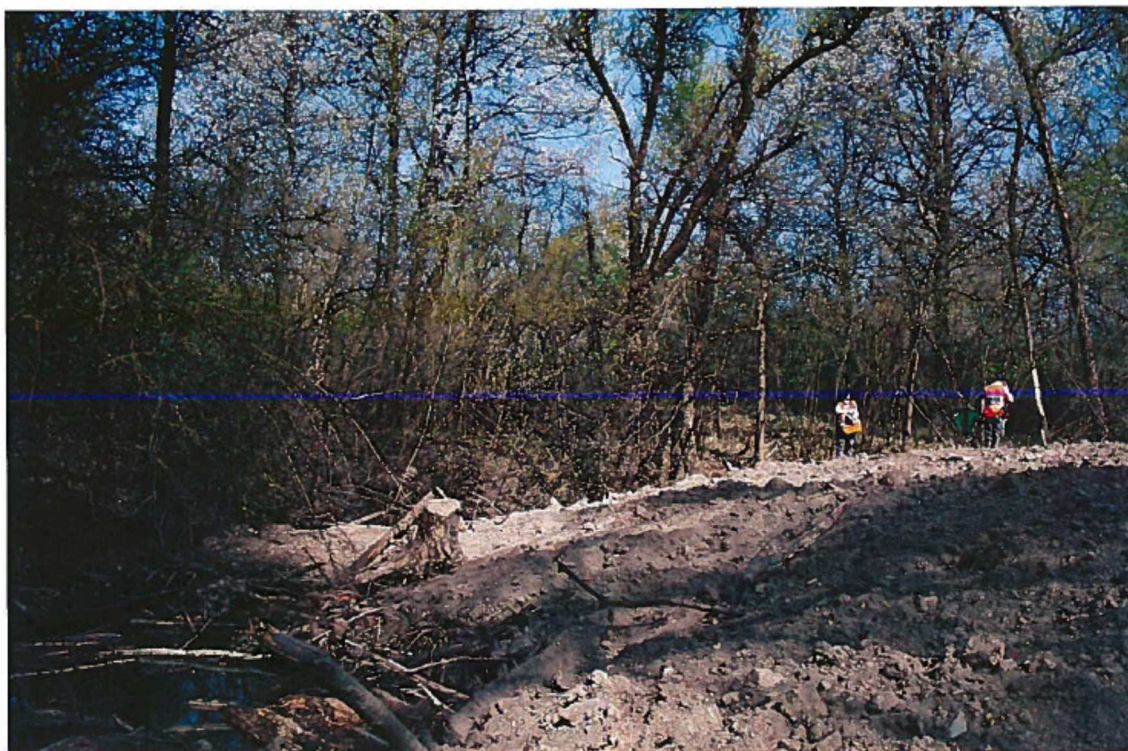
Talutage en pente douce - Photo DREAL Grand-Est prise le 31/03/17
