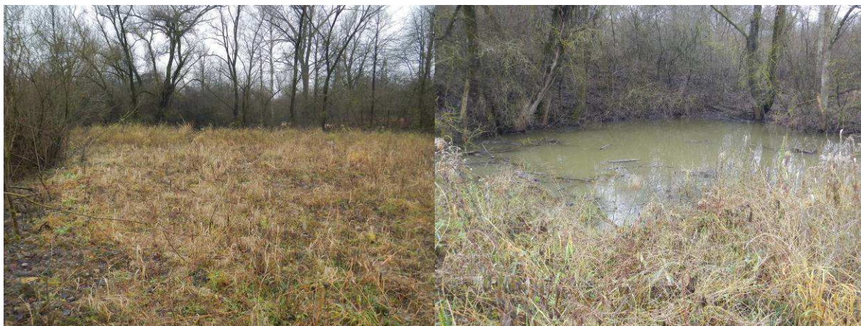
VUE DU SECTEUR DE LA MARE 2 APRES LES TRAVAUX : A GAUCHE VUE DU REMBLAI, A DROITE VUE DE LA PORTION DE MARE RESTANTE
