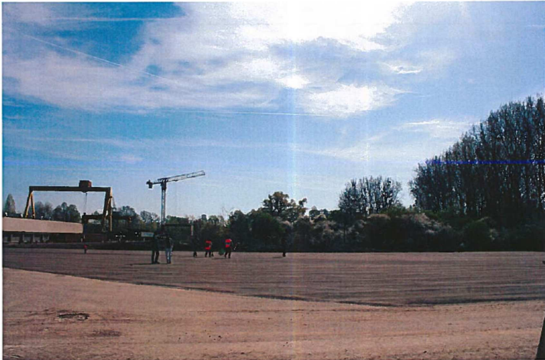
Plateforme de stockage de matériaux - Photo DREAL Grand-Est prise le 31/03/17
