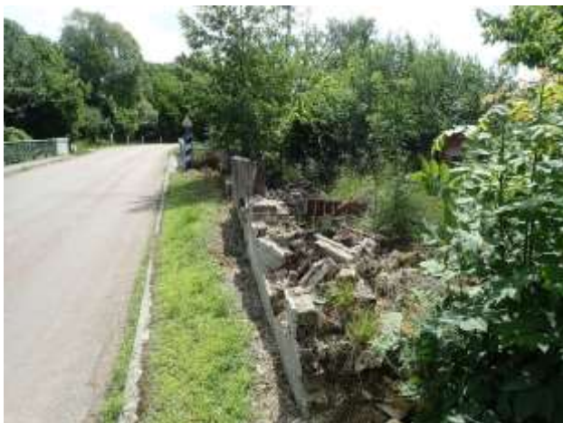
Figure 19 : Bâtiment du moulin démolé
