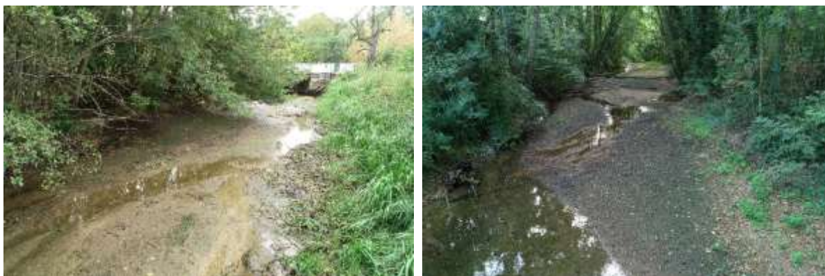
Figure 105 : Assècs récurrents dans le tronçon aval Tr1 du bief d'alimentation du moulin
