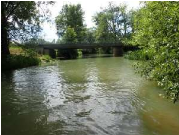
Figure 88 : Photographies du tronçon 6
