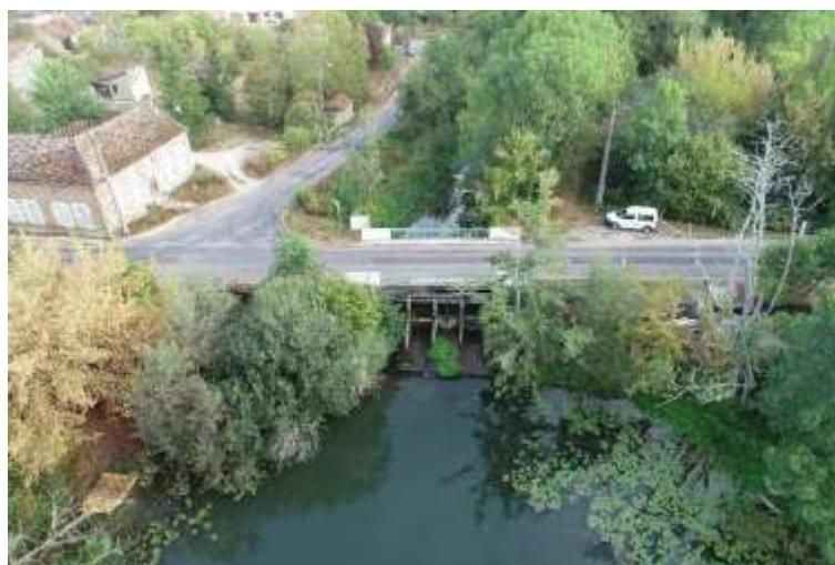
Figure 43 : Ouvrage OH1 sous la RD35
