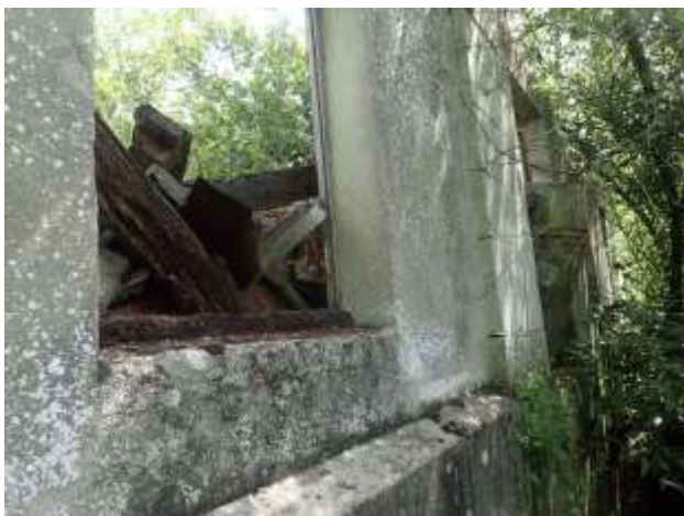
Figure 20 : Vestige du moulin démolé
