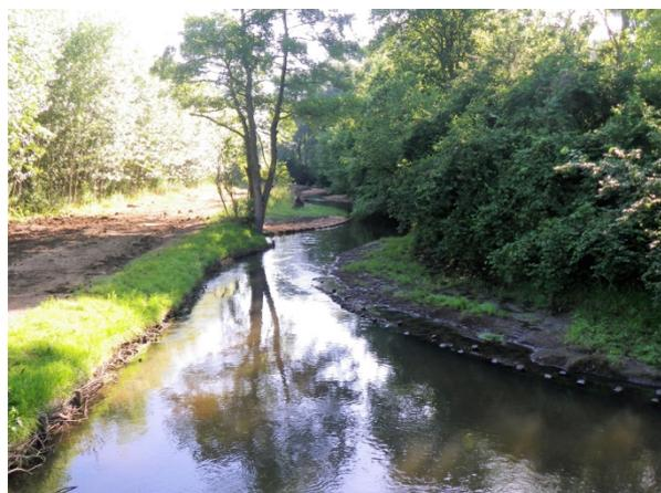
*Installation de bancs-risbermes dans l'Andlau (AND03) avec géotextile biodégradable limitant le départ de fines, CCCE/SMEAS/Parc d'Erstein, 2016.*
