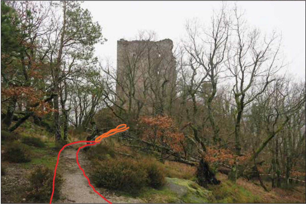
Figure 5 : Chemin d'accès existant dans le biotope, vue du nord vers le sud (vers le château)
