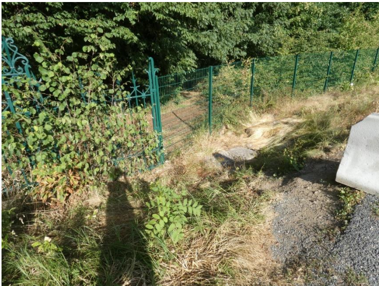
Photo 26 : Talus intermédiaire entre le parc Sainte-Marie et le parking du site de Grand Nancy Thermal.
