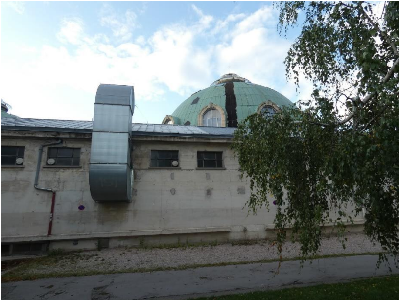
Photo 29 : Piscine du côté de l'Office Municipal des Sports, des Alytes accoucheurs ont été vus sur les zones en graviers
