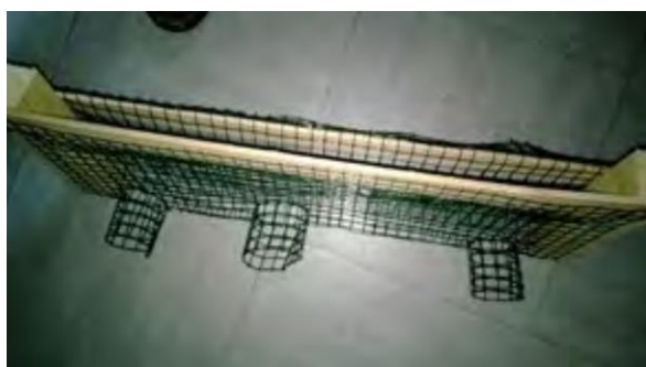
Figure 15 : Exemple d'un système anti-retour utilisé au niveau d'un disjointement
