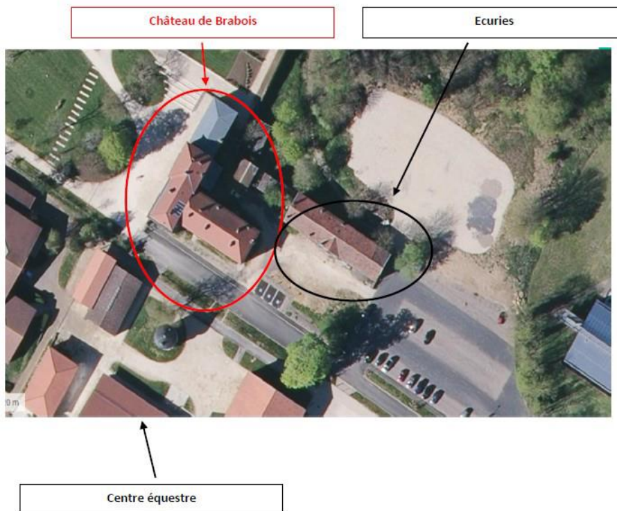
Figure 30 : Localisation des différents bâtiments
