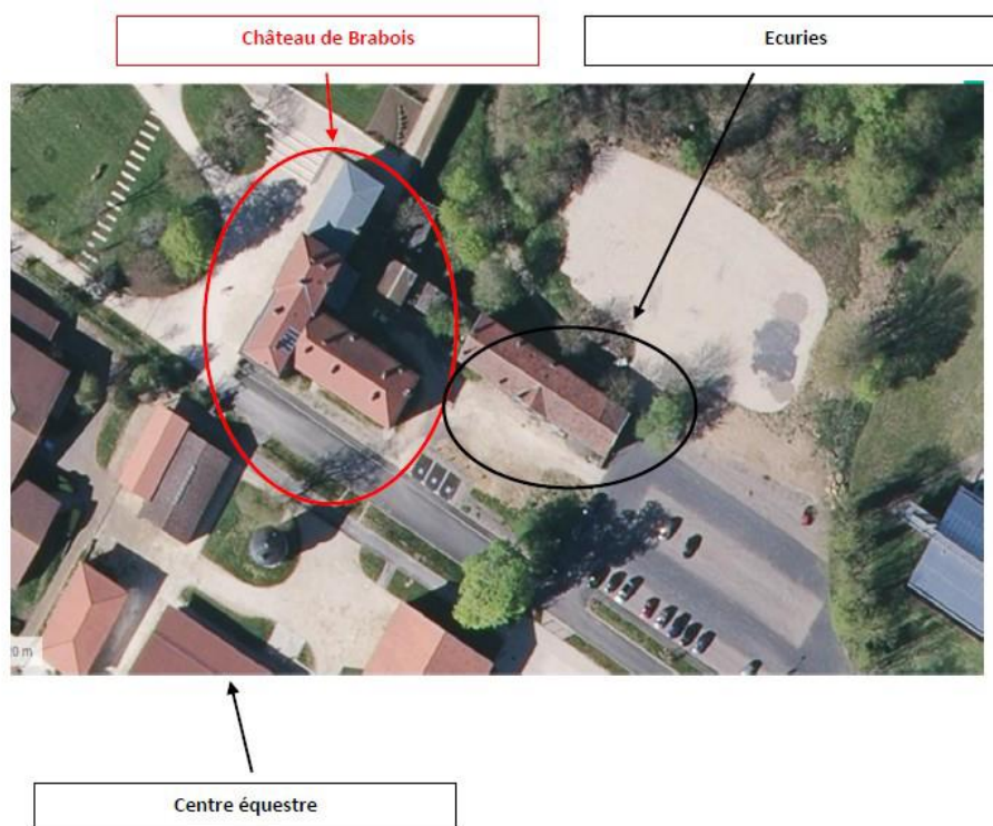
Figure 28 : Localisation des différents bâtiments
