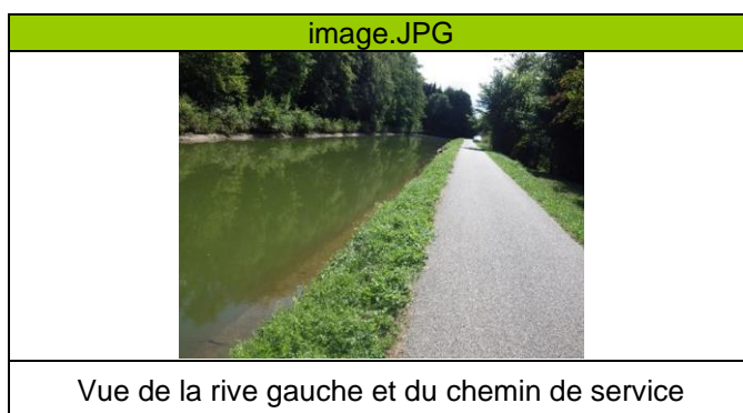
Photo 3 : illustration du canal sur le tronçon de travaux A
