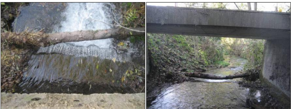
Vues sur la seconde chute de 33 cm le 26/10/2010.
