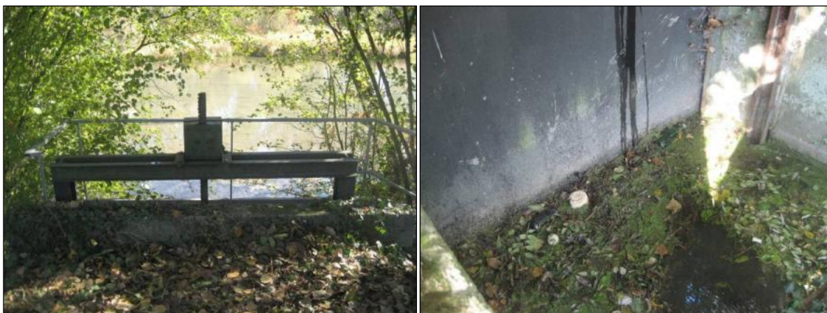
Vues sur l'ouvrage le 26/10/2010
