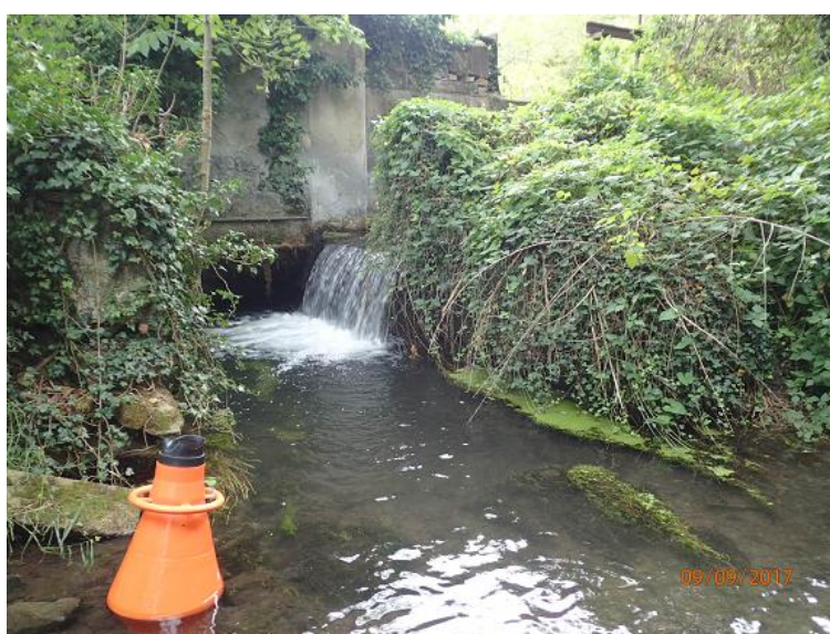
Figure 12 : Ouvrage OH 16, ancien moulin sur le site Faurecia à l'amont de Marckolsheim
