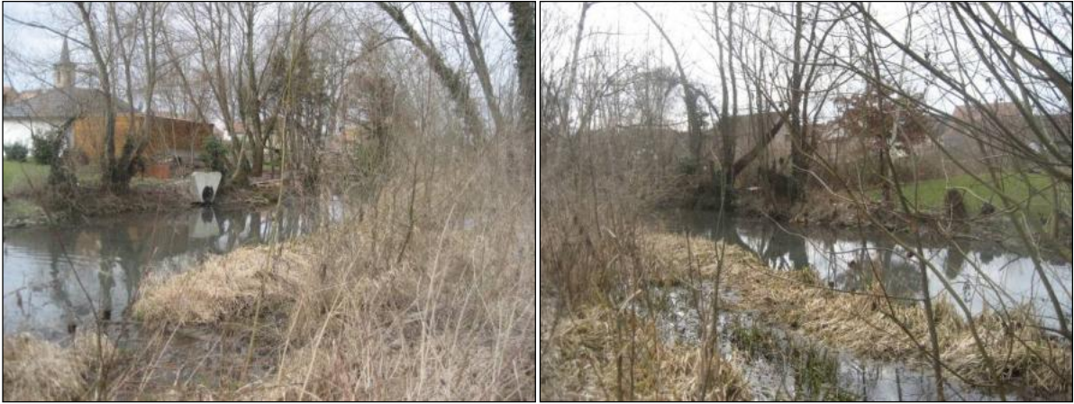
Les photos ci-dessus montrent les banquettes réalisées présentant localement un tassement le 08/03/2013.
