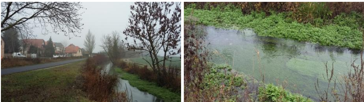
Ci-dessus, vues sur l'Ischert et la partie amont (parcelle 9) du futur aménagement. Les banquettes qui se sont formées naturellement par le développement de cressons et de myosotis seront conservées. Les banquettes ont permis de tendre vers un resserrement du lit de l'ordre de 3 m tel que visible sur la photo de droite (05/12/2018).
