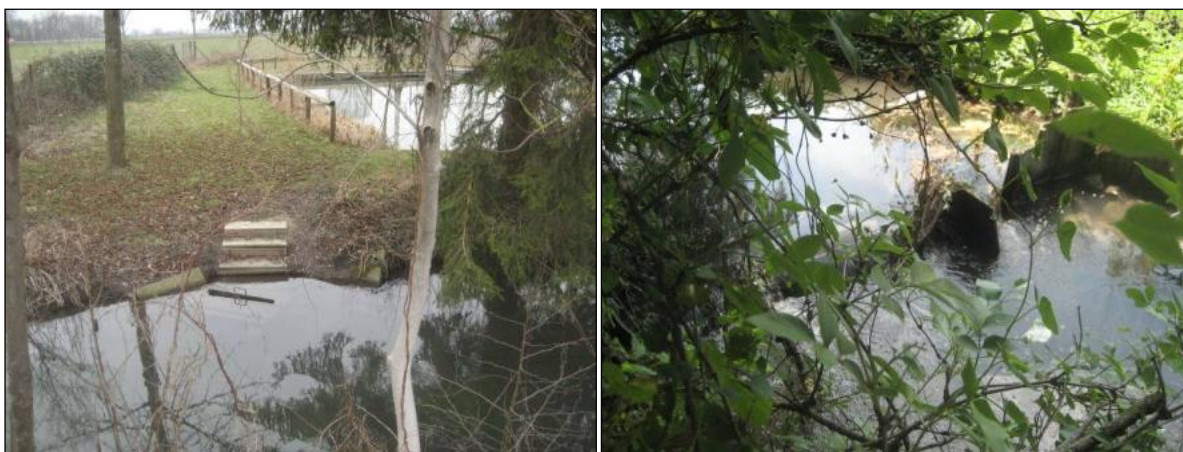
A gauche, vue sur l'ouvrage de prise d'eau le 08/03/2013 A droite, vue sur l'ouvrage le 13/07/2010
