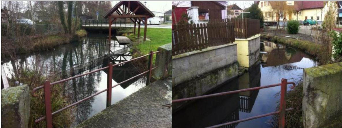
Prise d'eau amont (photo SINBIO)
