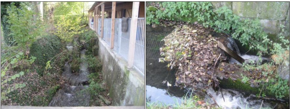
Vues sur la première chute de 61 cm le 26/10/2010.
