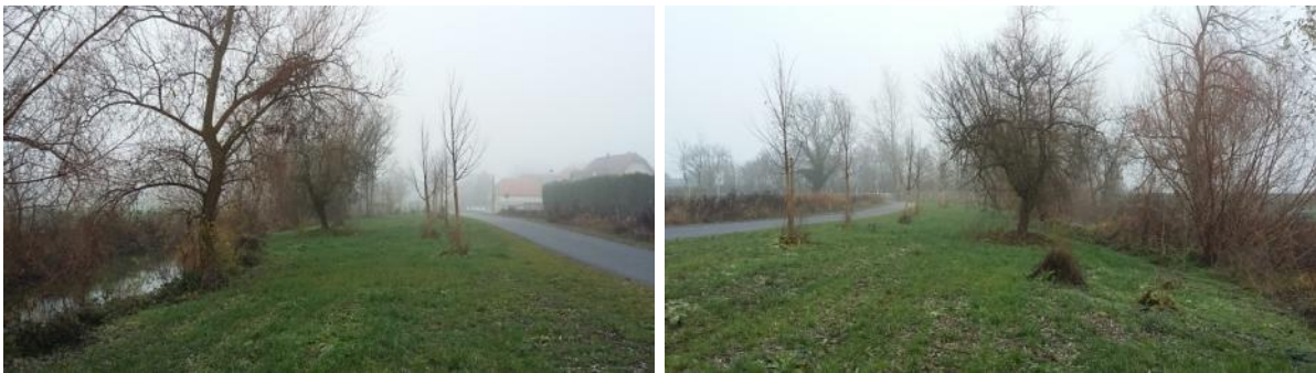
Ci-dessus, vues sur la berge en rive gauche de l'Ischert au droit de la parcelle 20. La berge sera décaissée entre l'Ischert et la piste cyclable le 05/12/2018.
