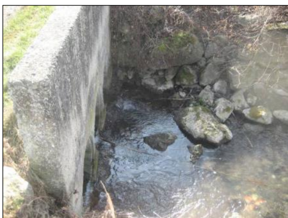
Vue sur la sortie des buses aval le 11/02/2011.
