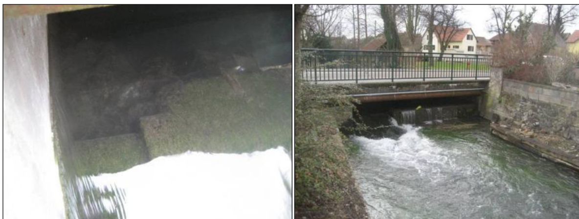
A gauche vue sur la partie visible du réseau d'assainissement le 08/03/2013 A droite vue sur l'ensemble de l'ouvrage le 08/02/2013.
