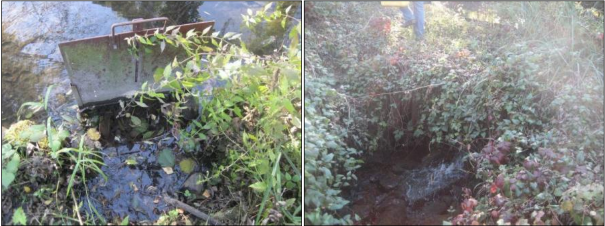
Vues sur la prise d'eau permettant l'alimentation du fossé le 26/10/2010.
