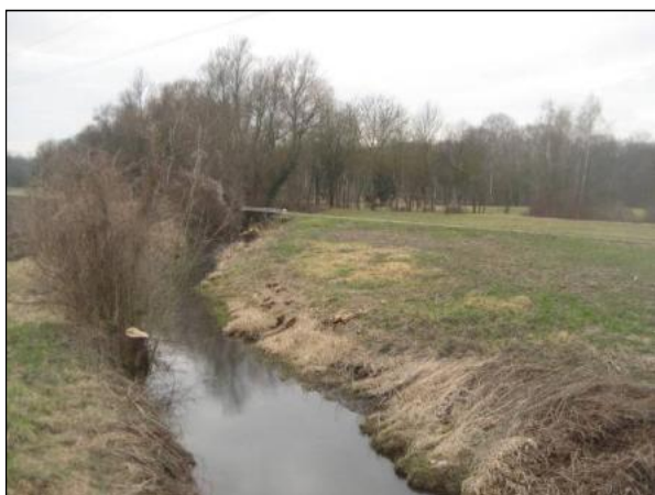
Ci-dessus, vue du site de l'aval vers l'amont le 11/02/2011.
