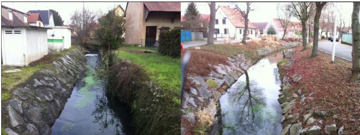
Le fossé des Remparts (photos SINBIO)
