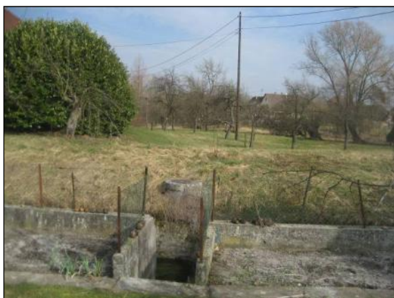
Vue sur le collecteur d'assainissement influençant les écoulements dans le Fossé des Remparts le 11/02/2011.
