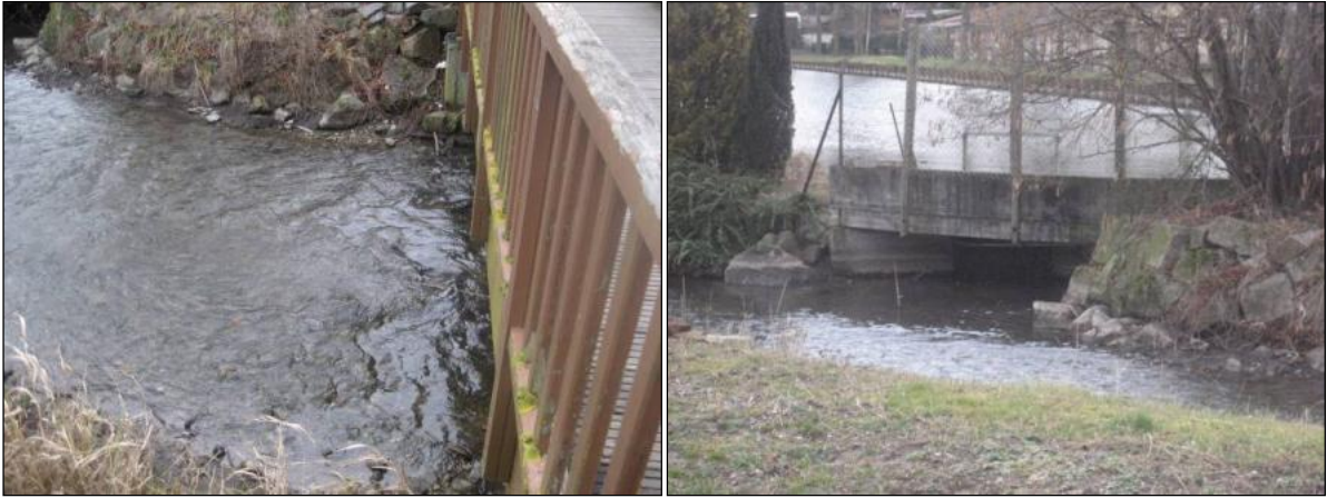
Vues sur les écoulements de l'Ischert avec une ouverture partielle de l'OH17 entre la rue du 42 ème RIF et la prise d'eau de l'étang de l'AAPPMA de Marckolsheim le 13/02/14.
