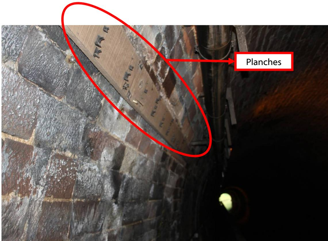
Figure 3 : Planches situées le long de la paroi du tunnel de Niderviller
