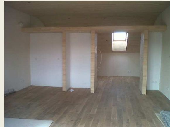
MilLieux architectes, logements collectifs à Nancy
