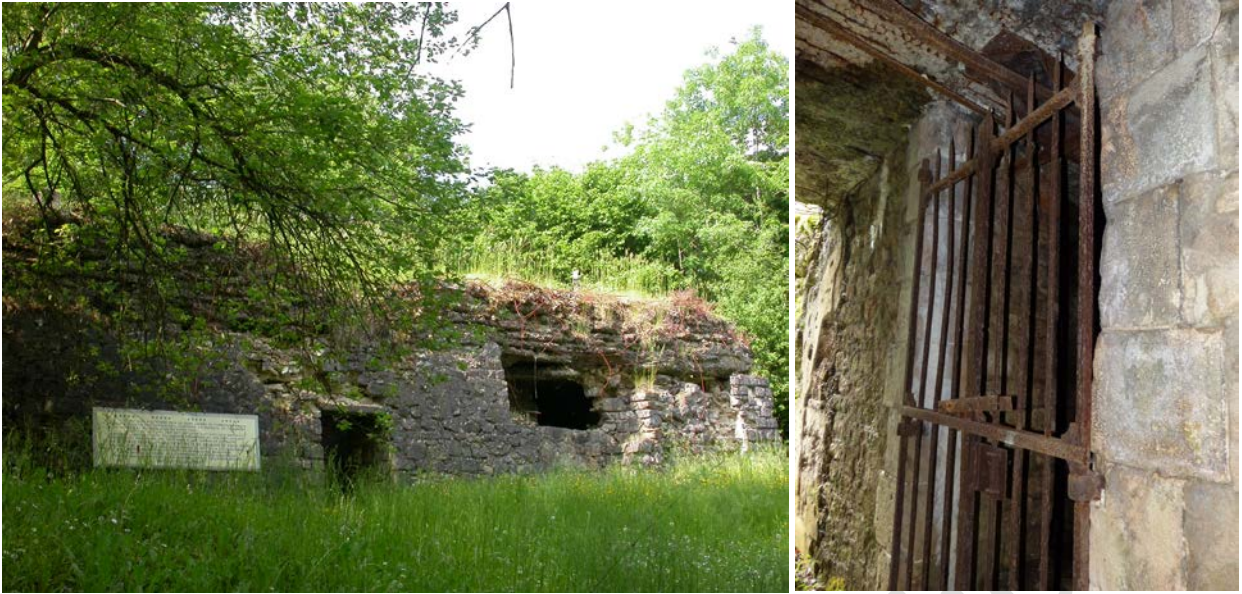
Figure 33 : Abri d'infanterie PC 119 (à gauche) ; grille d'origine (à droite)
