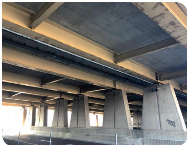
La seconde phase de la Rocade Sud nécessite des travaux de réhabilitation de cet ouvrage. Titulaire du marché, l'entreprise SAERT est chargée de la réfection totale du traitement anticorrosion et de la peinture de la structure métallique de l'ouvrage. Ces travaux impacteront successivement les deux sens de circulation de la D1083. Des itinéraires conseillés et des déviations seront mis en place afin de limiter les gênes à l'utilisateur.
