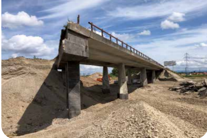
Déconstruction de l'ancienne A35
