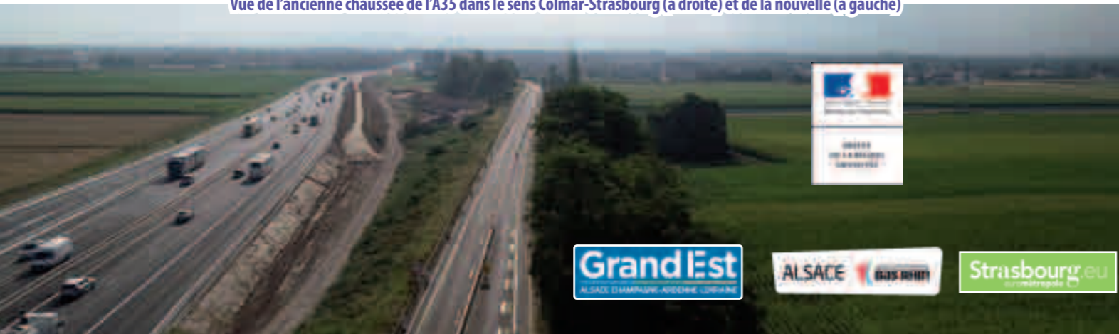
Vue de l'ancienne chaussée de l'A35 dans le sens Colmar-Strasbourg (à droite) et de la nouvelle (à gauche)
