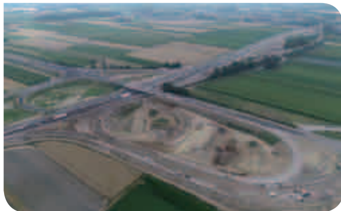
Vue de l'échangeur en travaux
