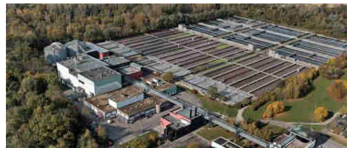
Station d'épuration de Strasbourg la Wantzenau
