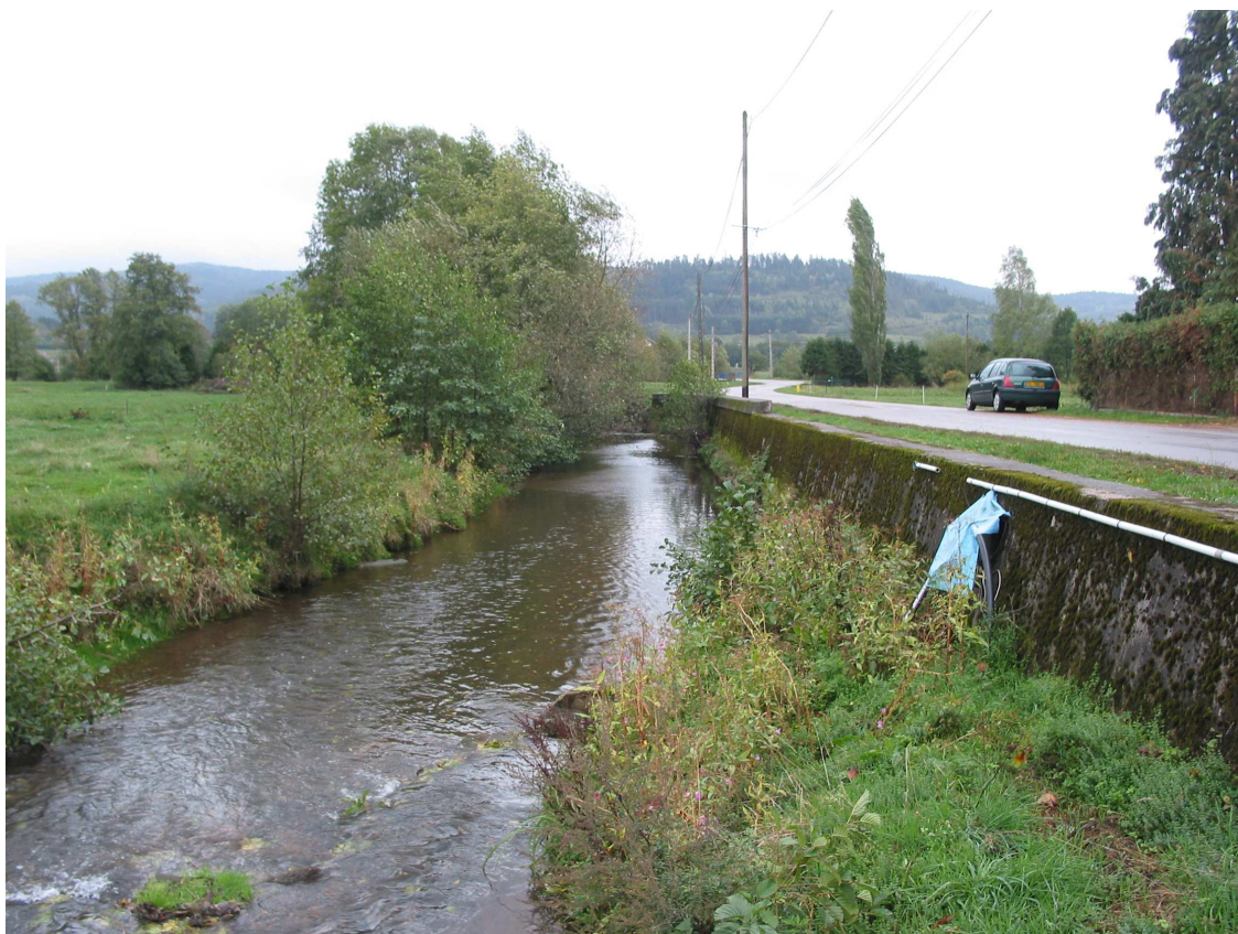
Photo n° 13 : La Fave à Frapelle : vue vers l'aval. Protection dure de la rive droite du fait de la présence de la route.
