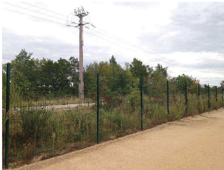
Figure 10 : Illustration d'une clôture installée (source : URBASOLAR, 2017)
