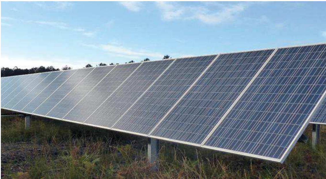
Figure 4 : Illustration de structures fixes sur pieux battus (source : URBASOLAR, 2018)
