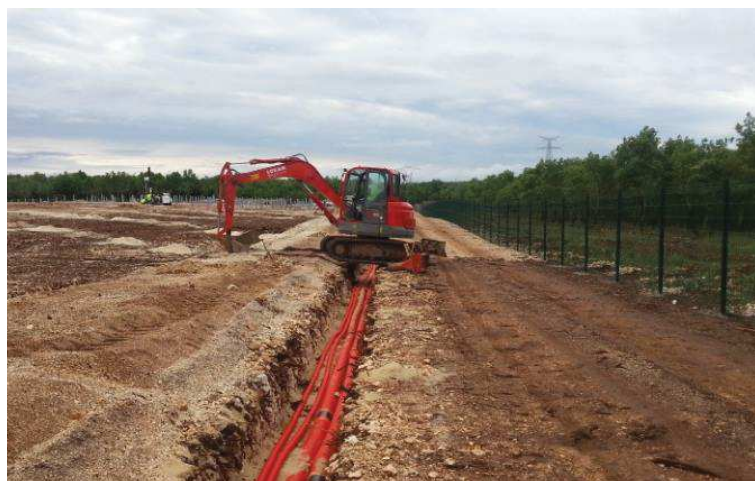
Figure 11 : Illustration de l'enfouissement d'un réseau électrique (source : URBASOLAR, 2017)
