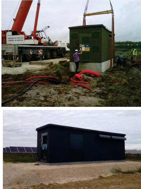
Figure 13 : Exemple d'acheminement d'un poste de livraison préfabriqué (source : URBASOLAR, 2017)
