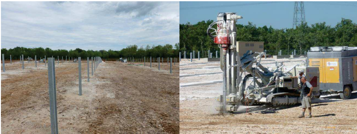
Figure 12 : Illustration de la phase de fixation des pieux battus (source : URBASOLAR, 2017)
