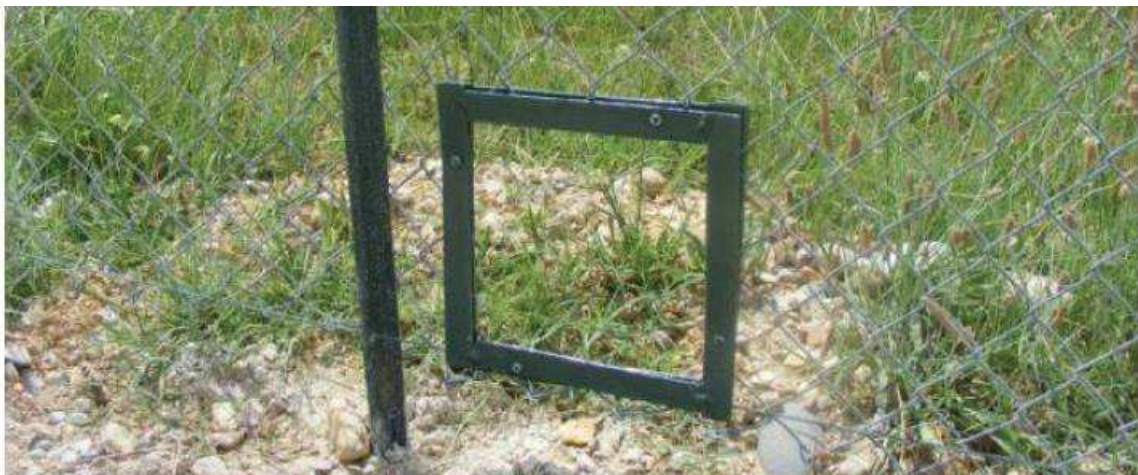
Figure 8 : Illustration d'une trappe pour la petite faune (source : URBASOLAR, 2019)
