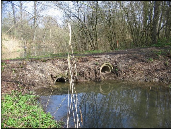
1 et 2 – La suppression des passages busés et leur remplacement par des passerelles a permis d'améliorer l'écoulement des eaux et de rétablir les continuités écologiques dans le Rossmoerder (photo avant/après).
