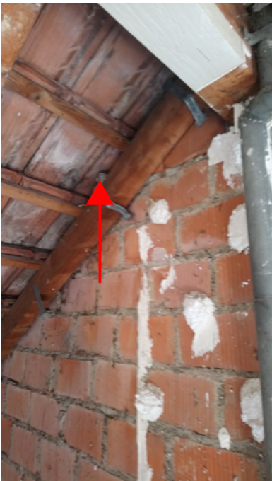
4 C est : déjections présence d'un nid de moineaux (?) (non visible) entre chevrons et tuiles
