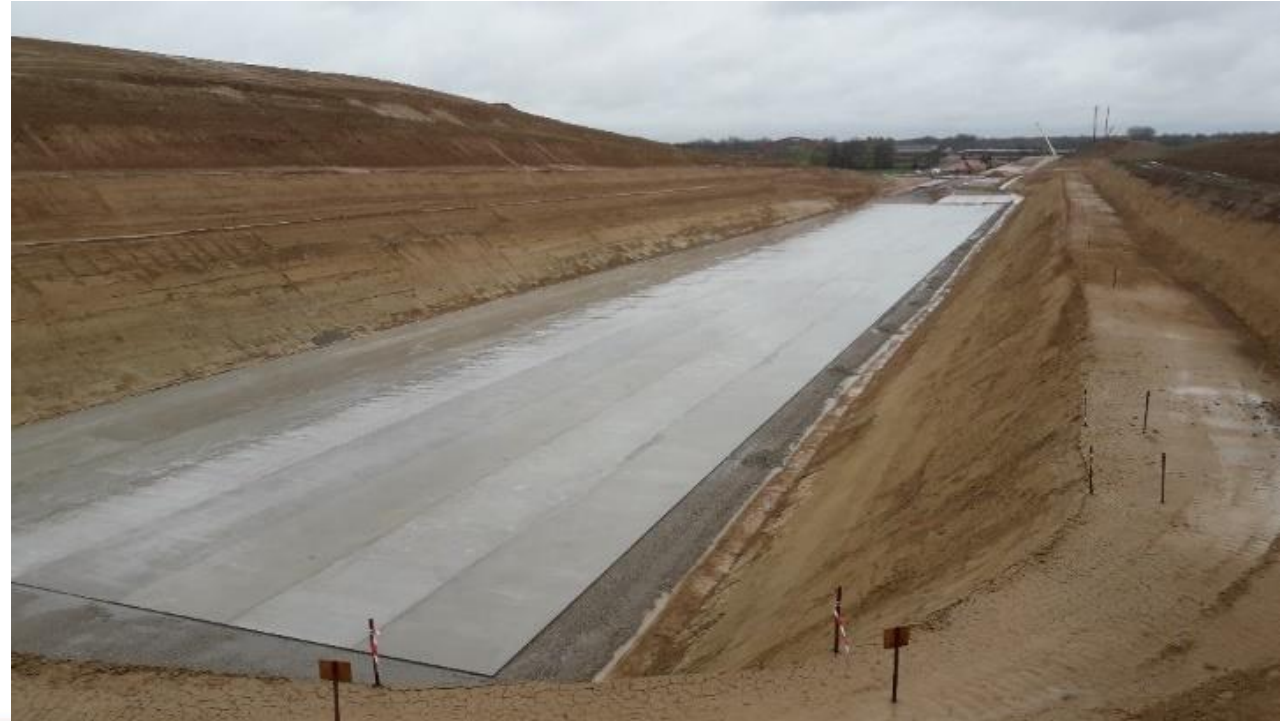
Tranchée Couverte de Vendenheim
