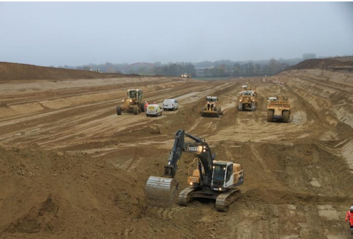
Terrassement de la tranchée couverte
