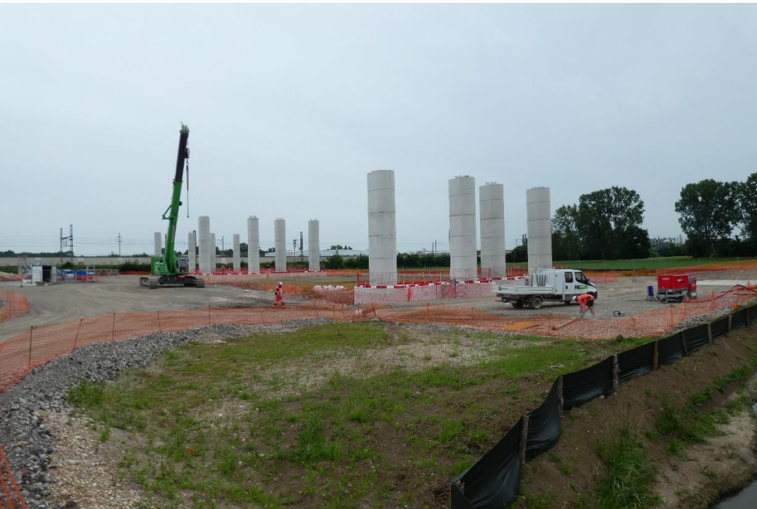
Viaduc de Vendenheim
