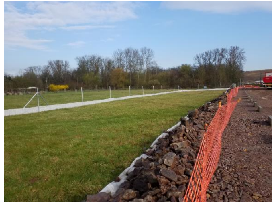
Clôture zone humide
