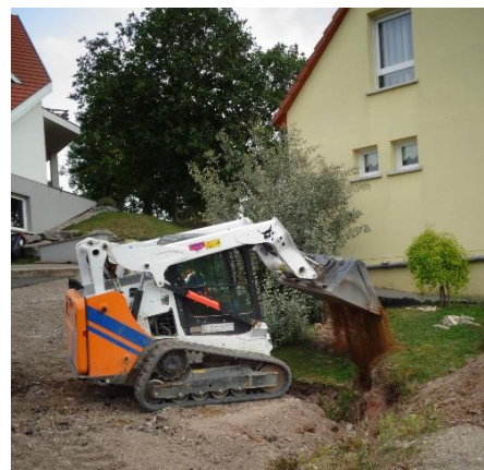
Colmatage des crevasses à l'aide de limons
