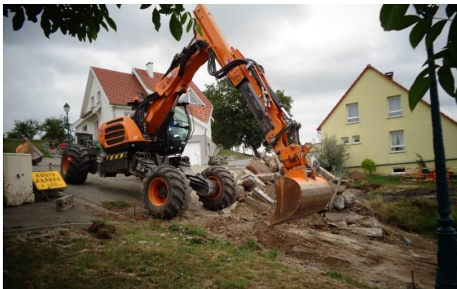
Décroustement de la voirie et dépose des longrines
