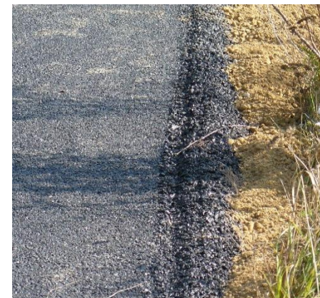
Bourellet de bitume pour canaliser l'eau de pluie
