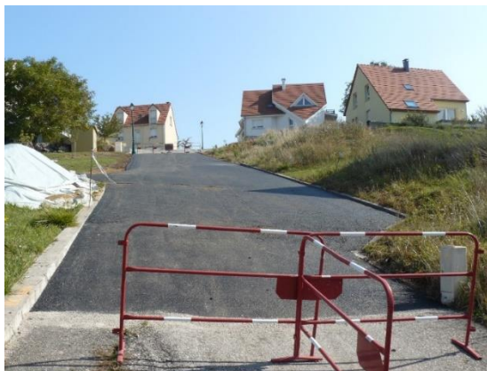
Zone de voirie traitée
