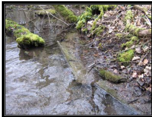
Document 8 : photo des sous-berges artificielles du tronçon 2 (mars 2008).
