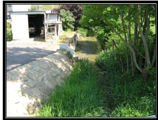
Document 36 : photo de l'aval du pont de la D952, vue vers l'aval (mai 2008).
