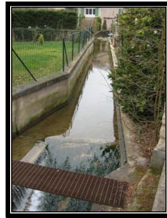
Document 14 : photo de la limite aval du tronçon 4, vue vers l'amont. Au premier plan, l'entrée du siphon limitant les tronçons 4 et 4bis (mars 2008).
