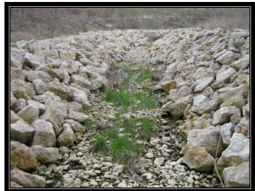
Document 25 : photo de l'aval du tronçon M2, vue vers l'amont (mars 2008).
