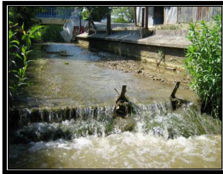
Document 37 : photo du seuil formé en aval du pont de la D952 sur le tronçon M5, vue vers l'amont (mai 2008).
