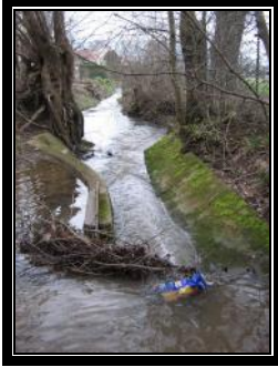
Document 33 : photo du seuil en béton en aval du tronçon M4, vue vers l'aval (mars 2008).
