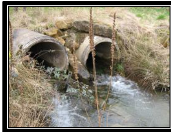
Document 12 : photo de la double buse présente en amont du trçon 3 (mars 2008).
