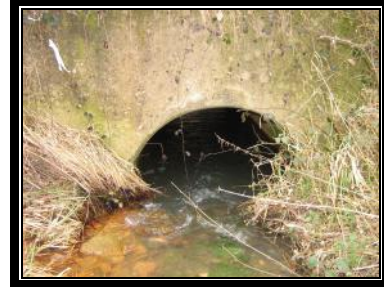
Document 34 : photo de la buse présente sur le tronçon M4 au niveau du 3 ème pont (mars 2008).
