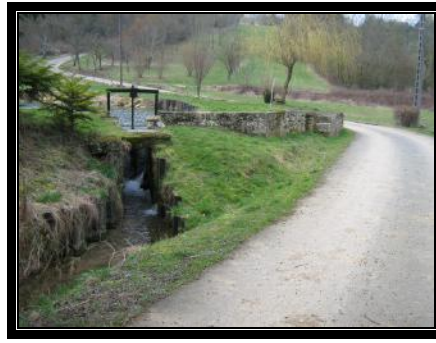
Document 30 : photo du seuil aval du 1 er plan d'eau, vue vers l'amont (mars 2008).
