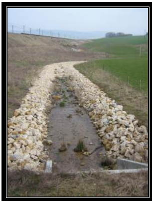
Document 24 : photo de l'amont du tronçon M2, vue vers l'aval, infiltration dans les calcaires (mars 2008).
