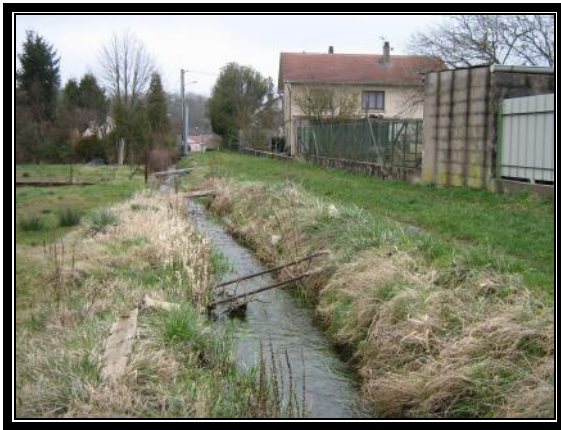
Document 13 : photo de l'amont du tronçon 4, vue vers l'aval (mars 2008).
